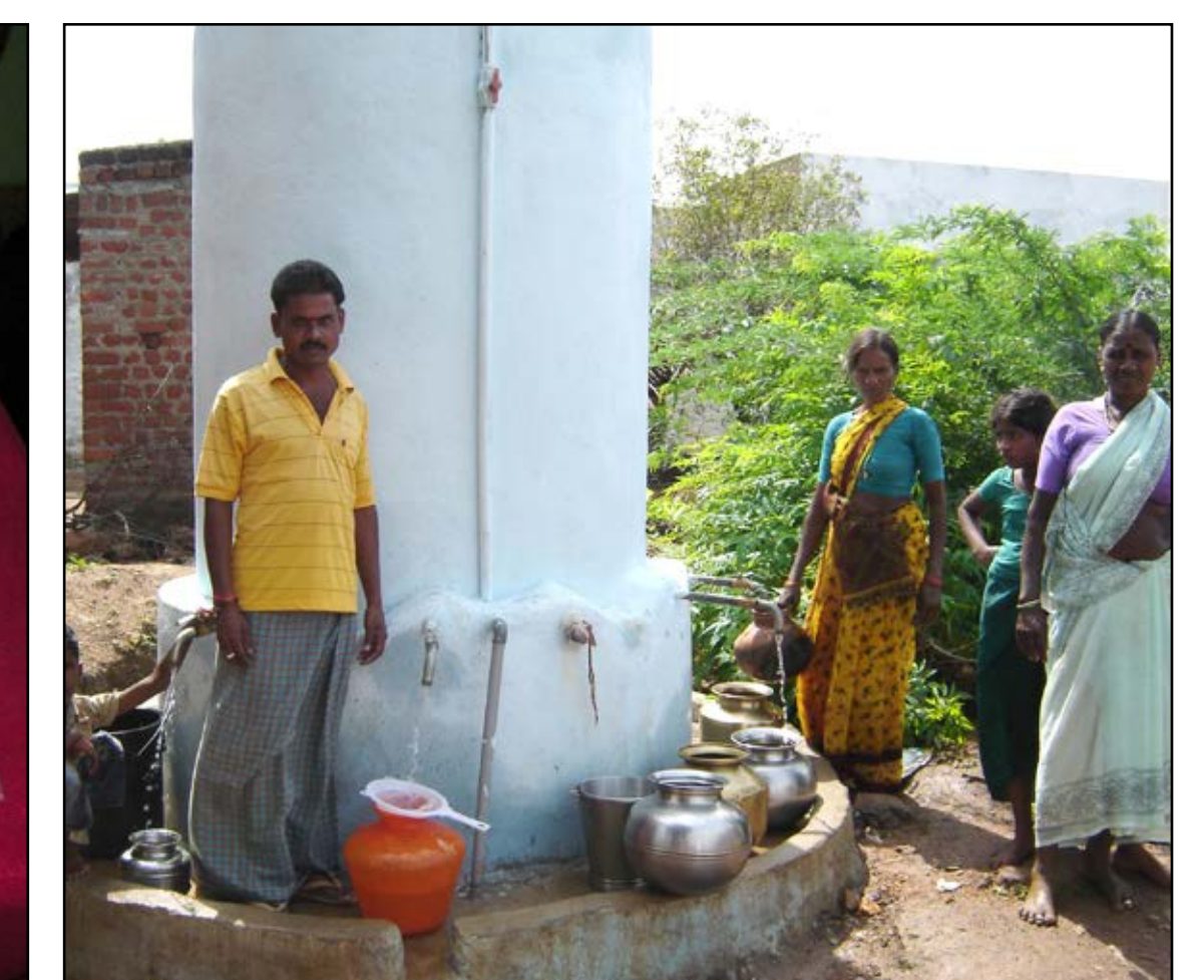
Fig.7. Mini water tanks (Aurepalle).
